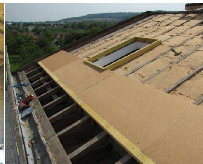
Isolation par l'extérieur = SARKING
