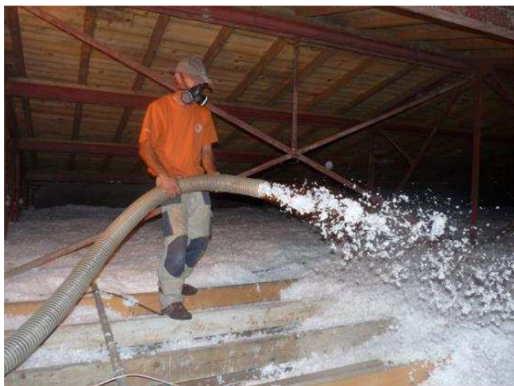
Isolation sur plancher
